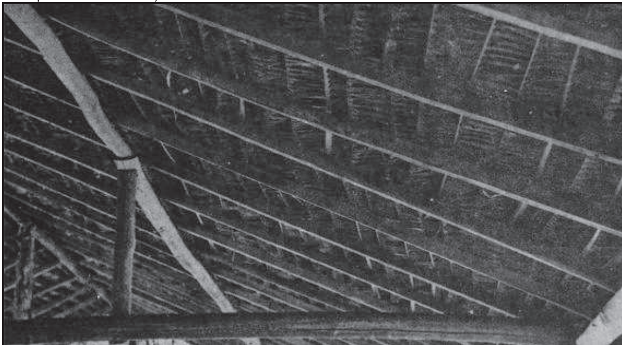
Figura 4 – Virada da palha. (Pescadores da região ensinam aos operários da prefeitura a virada de palha, para construir o teto do acampamento escolar. Essa técnica tinha sido esquecida pela mão de obra qualificada e urbana).
