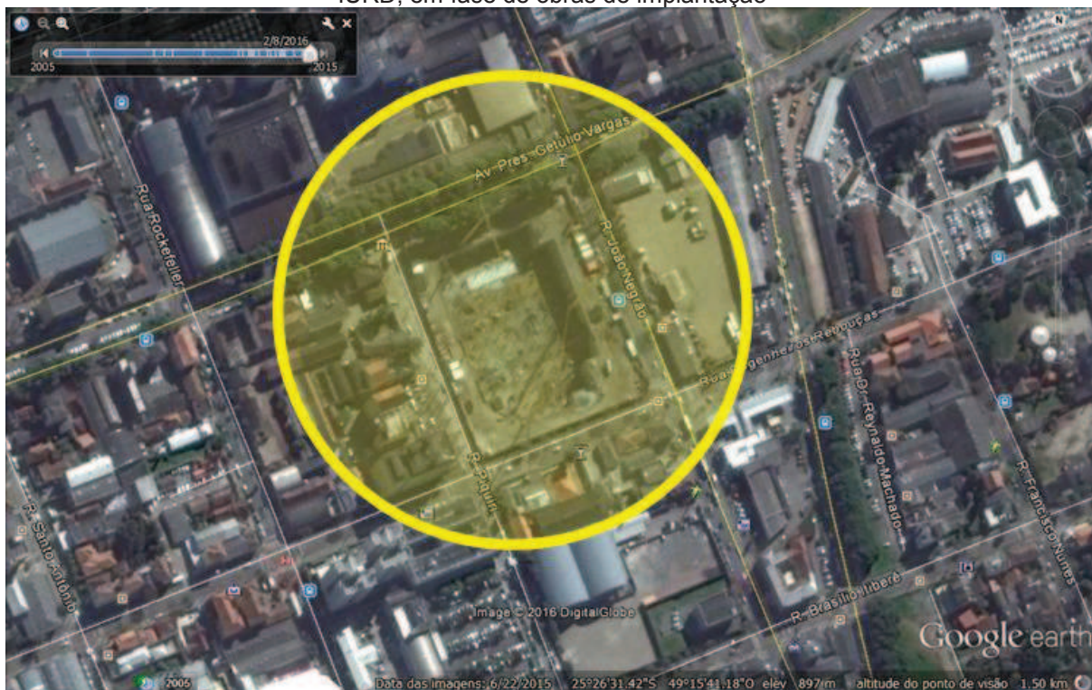
Figura 19 - Imagem aérea da localização do empreendimento Igreja Universal do Reino de Deus - IURD, em fase de obras de implantação
