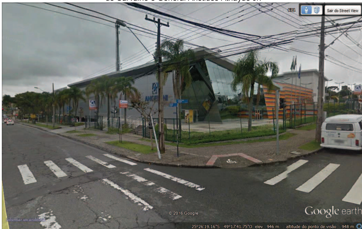
Figura 13 - Vista do empreendimento Angeloni Supercenter a partir da esquina entre as ruas Carlos de Carvalho e General Aristides Athayde Jr.
