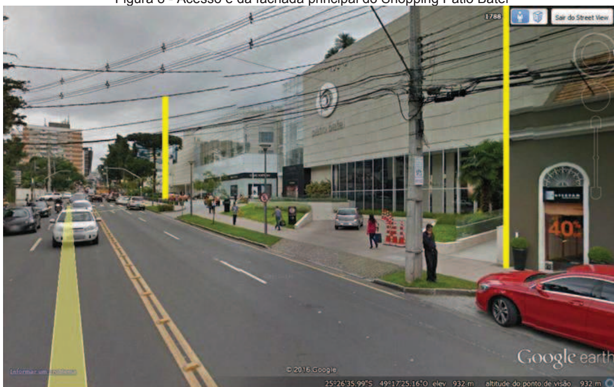
Figura 8 - Acesso e da fachada principal do Shopping Pátio Batel
