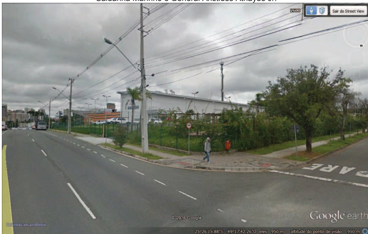
Figura 14 - Vista do empreendimento Angeloni Supercenter a partir da esquina entre as ruas Saldanha Marinho e General Aristides Athayde Jr.
