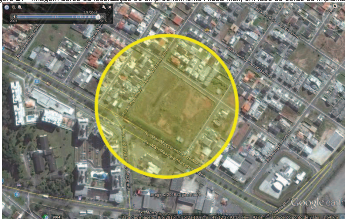
Figura 21 - Imagem aérea da localização do empreendimento Atuba Mall, em fase de obras de implantação
