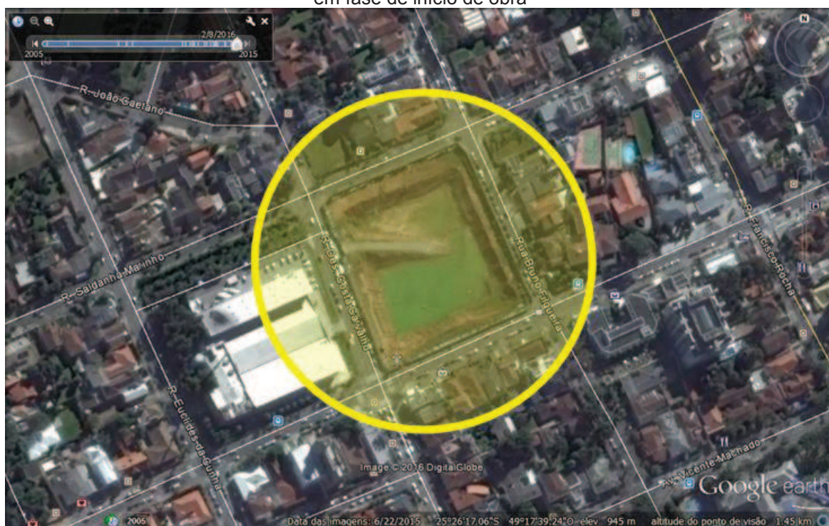
Figura 15 - Imagem aérea da localização do empreendimento Centro Comercial Invest-Terra, ainda em fase de início de obra
