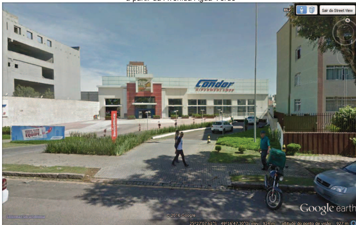
Figura 18 - Vista da fachada do Centro Hipermercado Condor Água Verde, a partir da Avenida Água Verde
