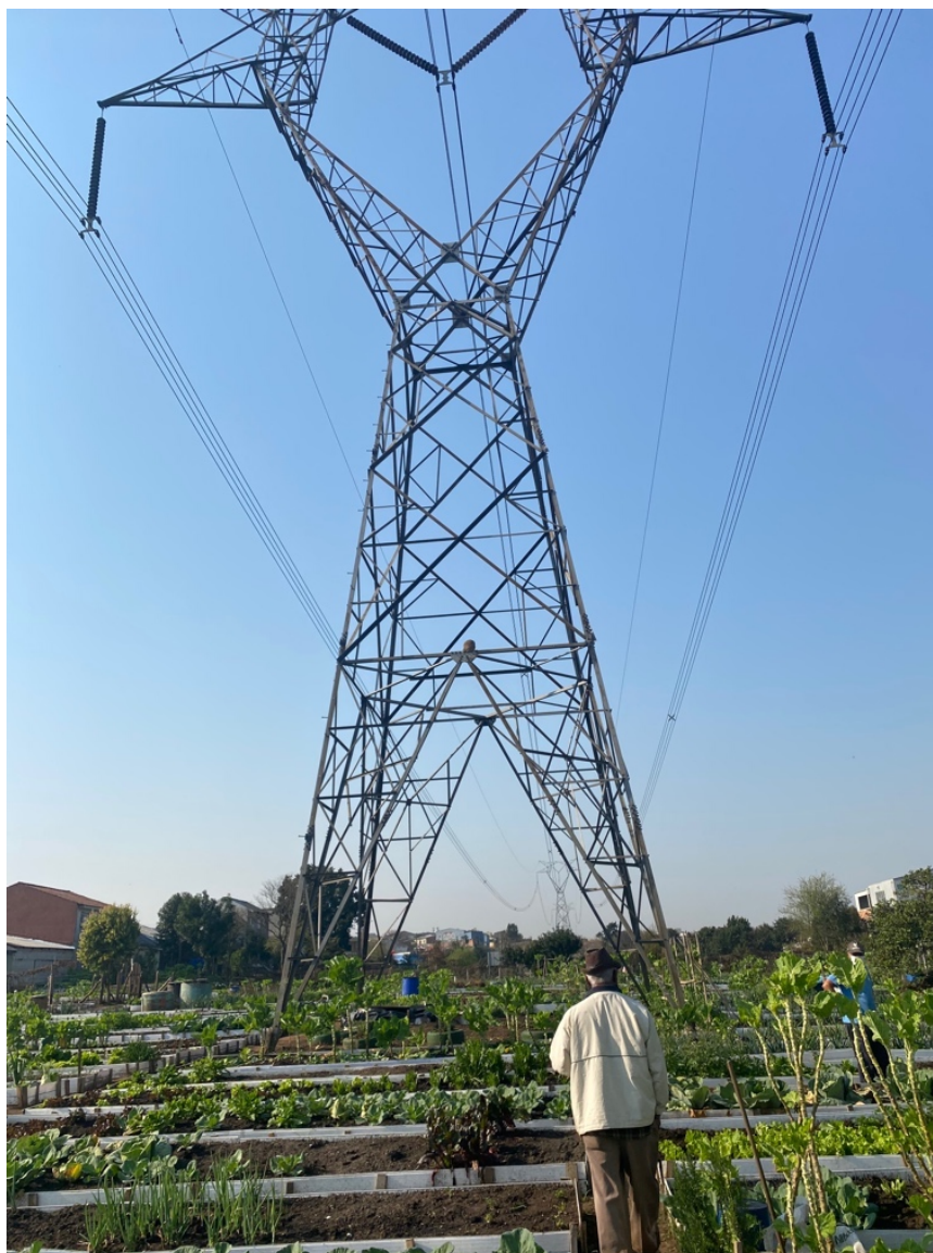
Figura 13 – Bairro Tatuquara, torre de alta tensão, com uso abaixo
