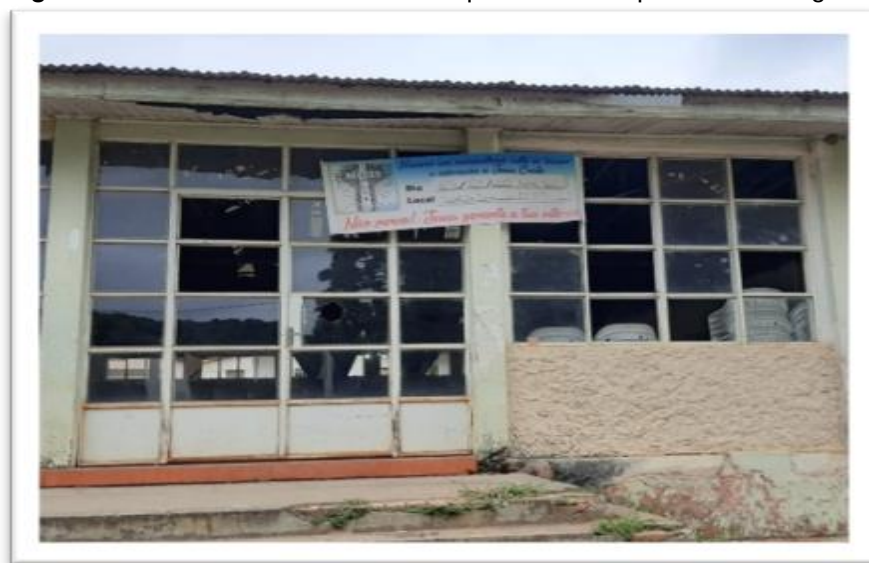
Figura 35 – Estrutura não restaurada que é utilizada para cultos religiosos
