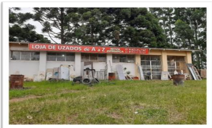
Figura 28 – Loja de móveis usados em estrutura restaurada
