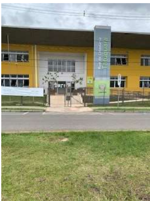
Foto 4 – Rua da cidadania Tatuquara (equipamento urbano)
