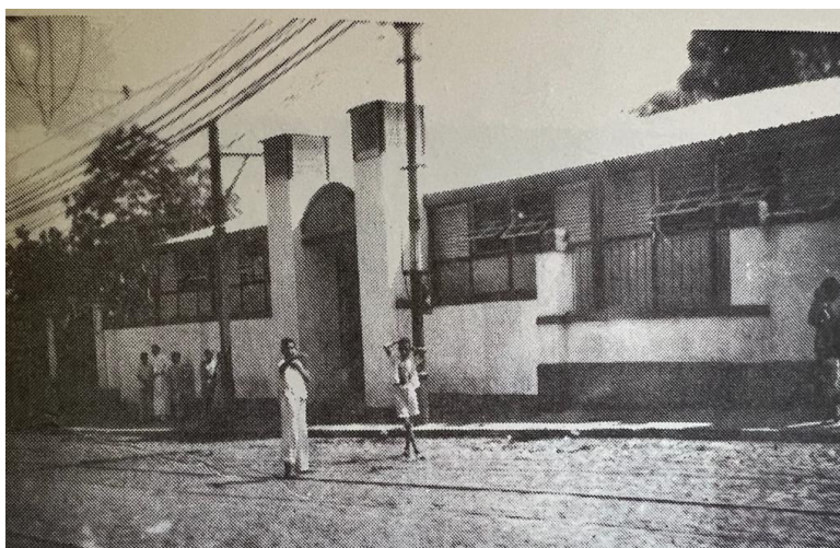
Figura 3- Foto da primeira igreja de Nossa Senhora Aparecida
